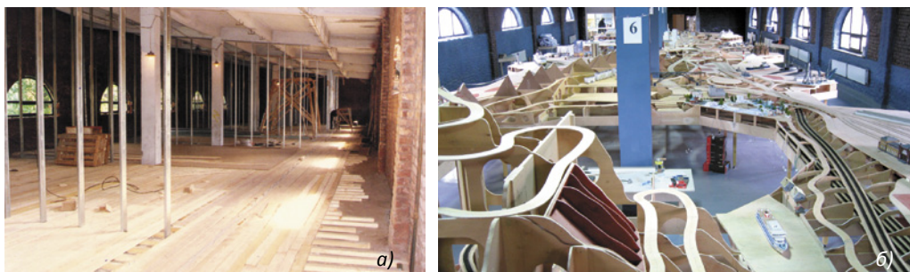
Рис. 2 – Этапы строительства «Гранд Макета Россия»: а) процесс переоборудования помещения на ул. Цветочной, 16; б) установка связующих рёбер и укладка основы железных и шоссейных дорог
